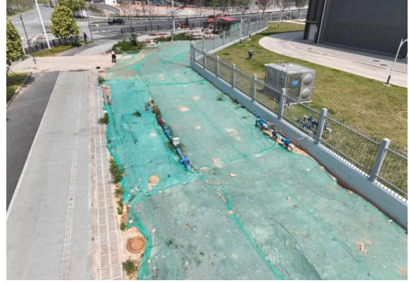
施工后覆盖密目网
