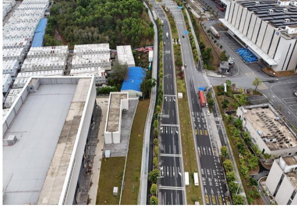
电缆线路沿线恢复情况
